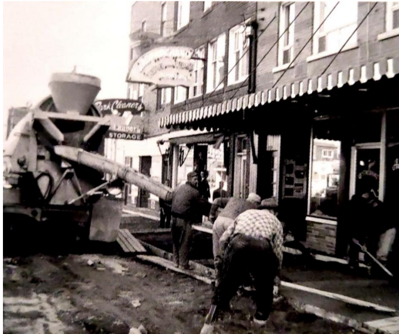
Photographie 1 : Construction de trottoirs en ciment sur l'avenue Principale en 1963 (tiré du Comité des festivités du 75e anniversaire de Rouyn-Noranda, 2001 ; Bolduc, 1963)
