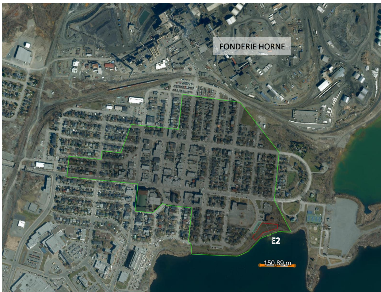
Photographie 7 : Contours de la zone drainée (en vert) ruisselant dans les bouches d'égout et se déversant par E2 dans le lac Osisko (tiré de Esri Satellite, 2023)
