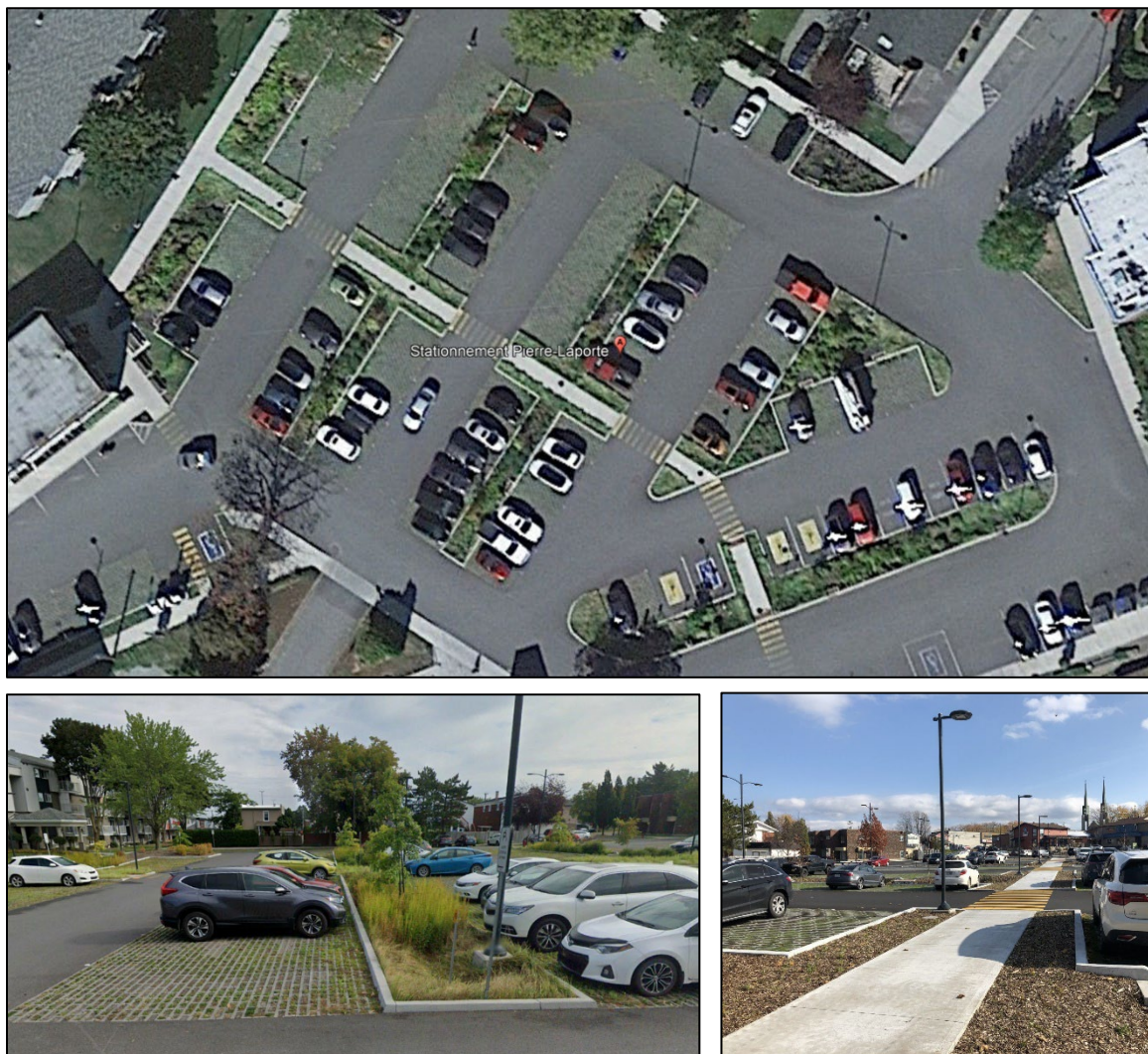
Figure 7-4 : Systèmes de gestion des eaux pluviales – Stationnement Pierre-Laporte – Biorétention et dalles alvéolées engazonnées
